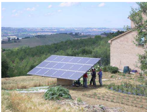
Esempi di impianti non integrati architettonicamente
